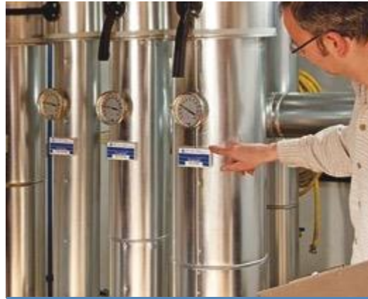
Kommunale Gebäude und Anlagen
