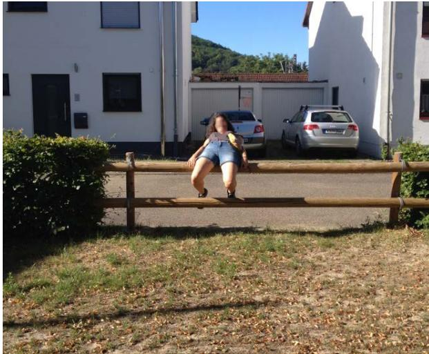
Abbildung 7 - Querholme sind als Einfriedung nicht geeignet, da sie unmittelbar am Fahrbahnrand einladen sich darauf zu setzen.
