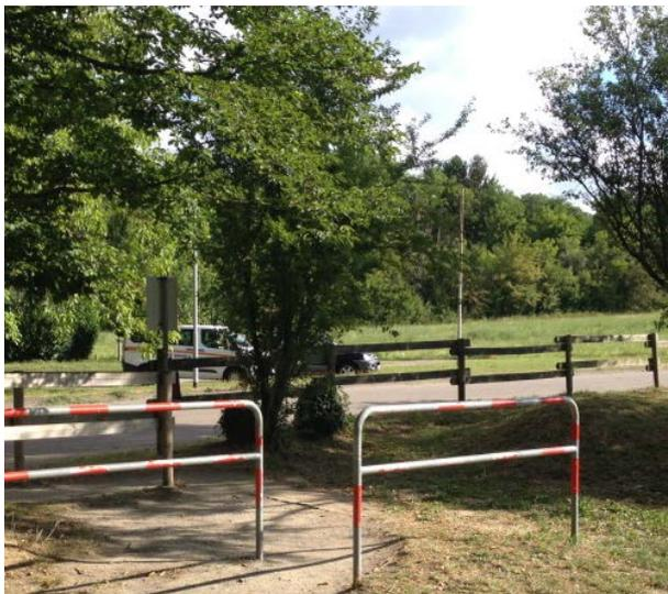
Abbildung 9 - Querholme entlang der stark befahrenen Weitherstraße stellen keine ausreichende und sichere Einfriedung dar
