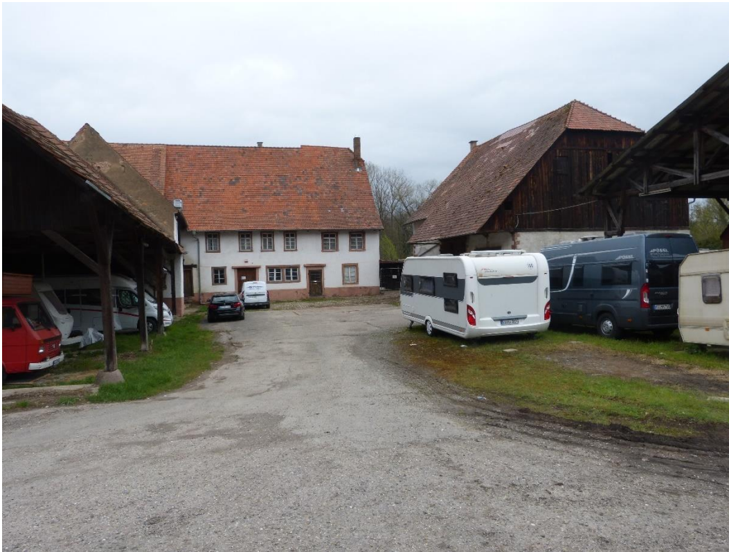
Bild 1: Schnellermühle mit angrenzenden Scheunen und weiteren Wirtschaftsgebäuden.
