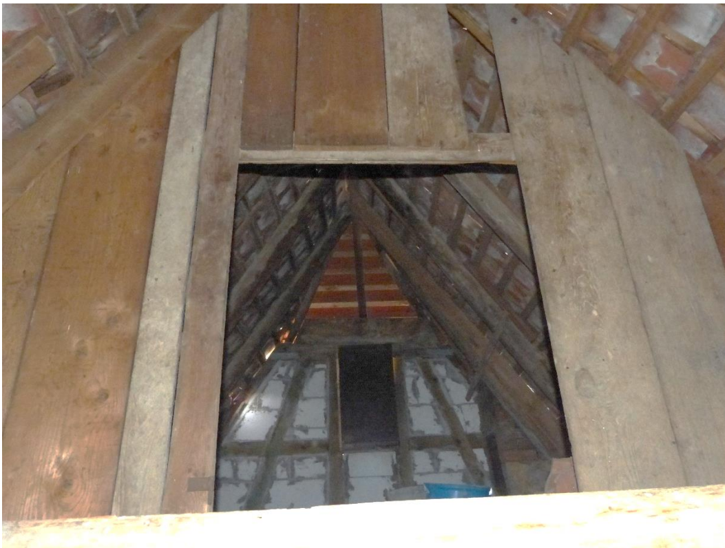
Bild 2: Dachboden der Schnellermühle.
