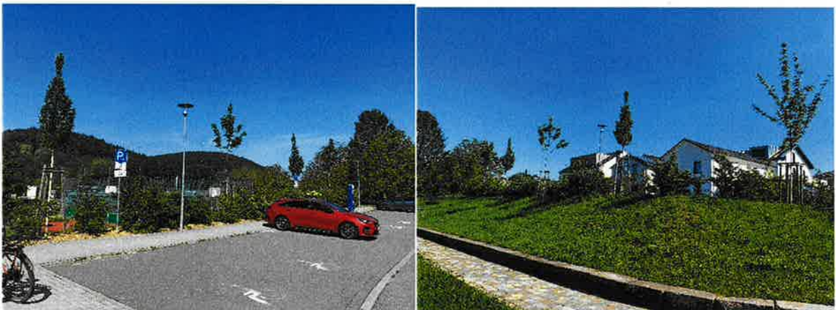
Abbildung 3 Sicht auf den Standort der geplanten Lärmschutzwand aus Osten bzw. Westen
