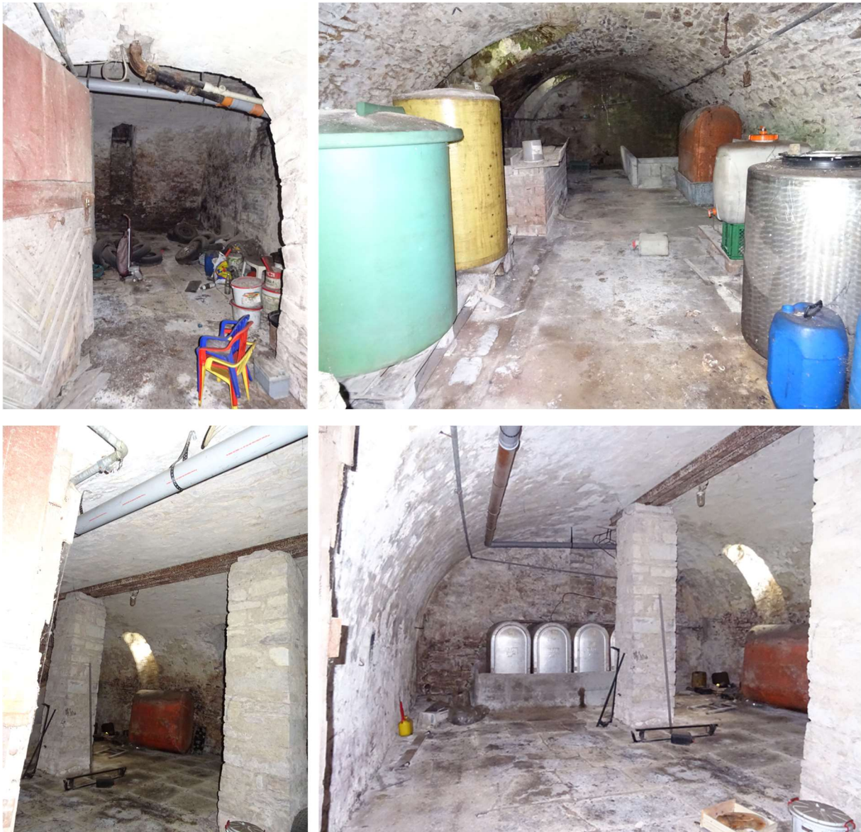
Abbildung 4: Keller des leerstehenden Wohngebäudes. Fotos: A. Konrath.
