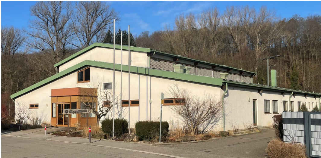
Unveränderte Bausubstanz seit Bau (1988)
