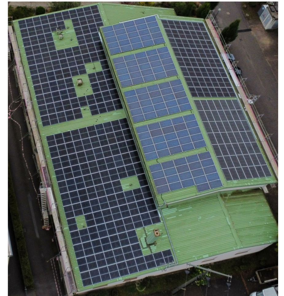
180 kWp bieten gute Voraussetzung für nachhaltige Wärmezeugung über Wärmepumpe
