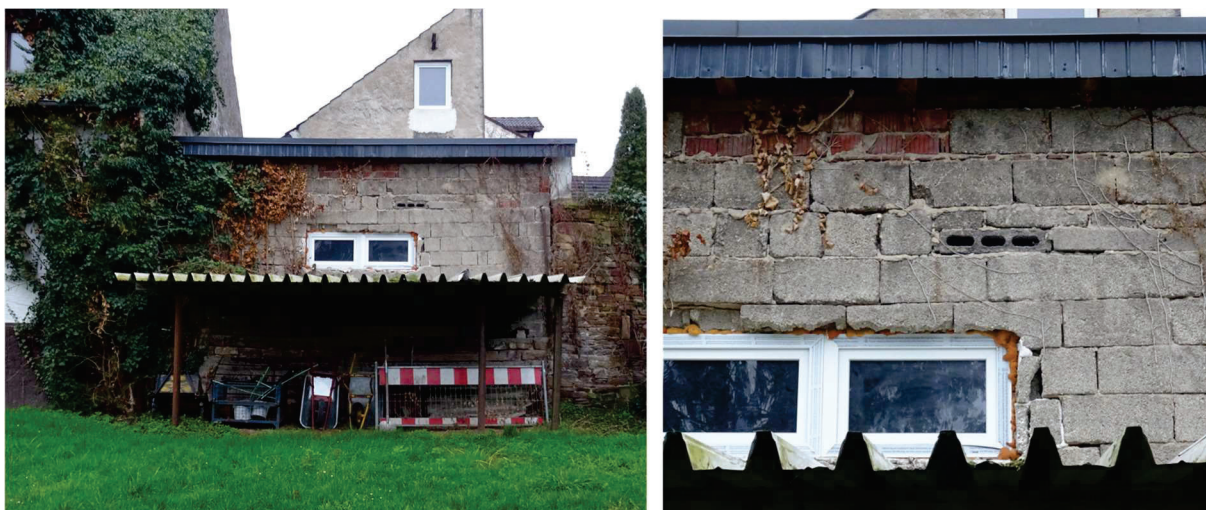
Abbildung 5: Wohnhaus mit angrenzendem Nebengebäude und Hohlbaustein in der Fassade. Fotos: A. Konrath.
