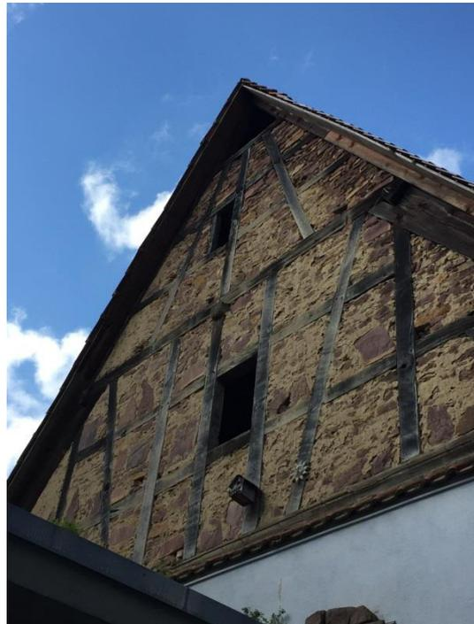
**Abbildung 4.1-5.** Lüftungsöffnungen in den Giebelwänden der Scheunen von Karlsruher Straße 65 (links) und Karlsruher Straße 55 (rechts).
