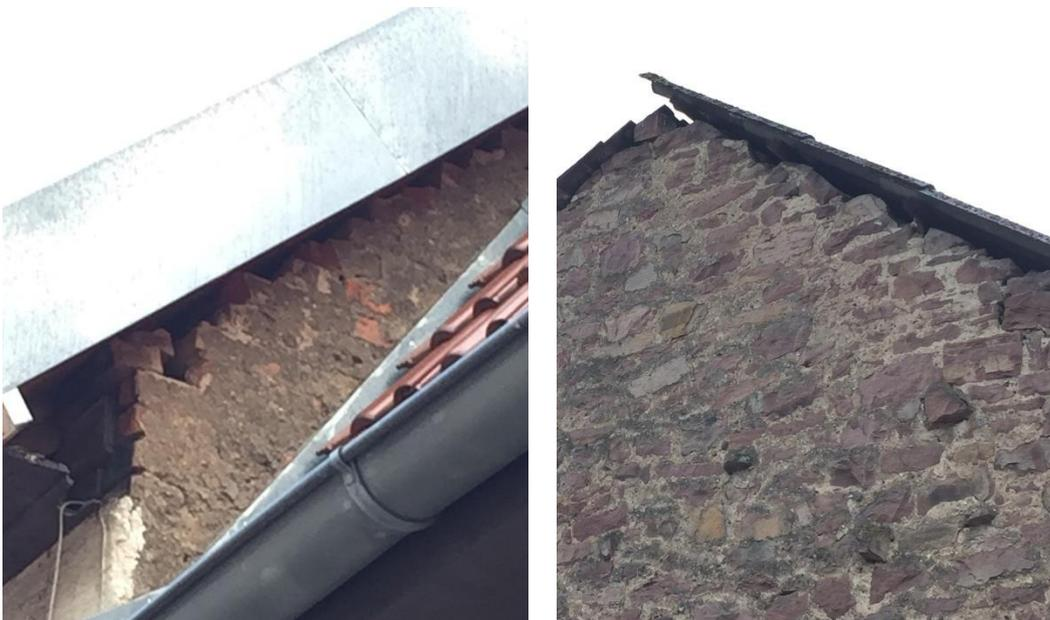
**Abbildung 4.1-7.** Spalten zwischen der Giebelmauer und dem Dach an Gebäuden der Karlsruher Straße 73.
