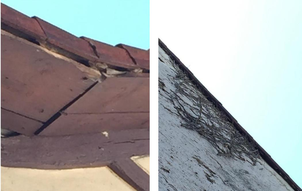
**Abbildung 4.1-6.** Spalten zwischen der Vordachverschalung und den Ortgangziegeln (links) und Slaten zwischen der Giebelmauer und dem Dach (rechts) an Gebäuden der Karlsruher Straße 81.
