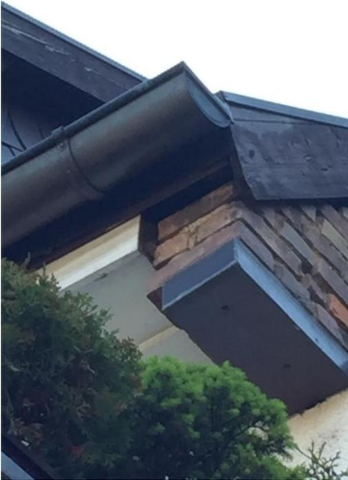
**Abbildung 4.1-2.** Spalt zwischen Giebelwand und Dachtraufe am Gebäude der Brückstraße 1.
